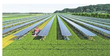
Symbolbild für eine Agri-PV-Anlage. Die Module werden so hoch montiert, dass Landwirtschaft möglich ist. FOTO: EWS CONSULTING GMBH
